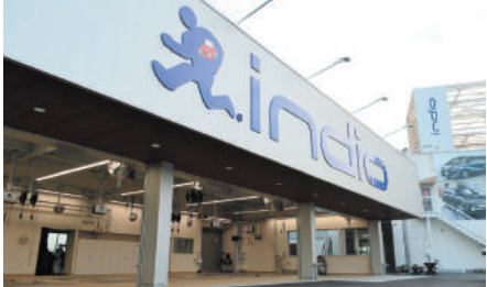
フルフラット仕様の6レーン完備
