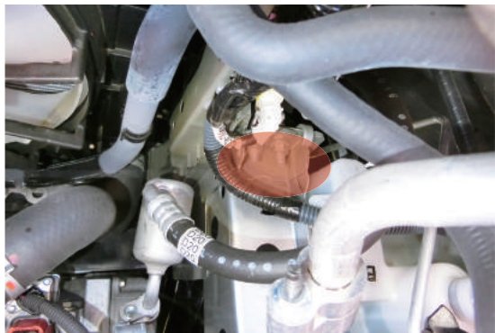
サイドメンバーとラジエータコアサポートの接合部分の状態を確認しましょう（画像は右側）
