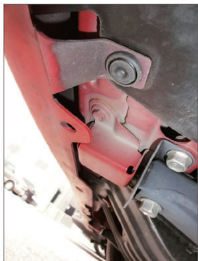
画像③フロントクロスメンバーを下側からチェック
