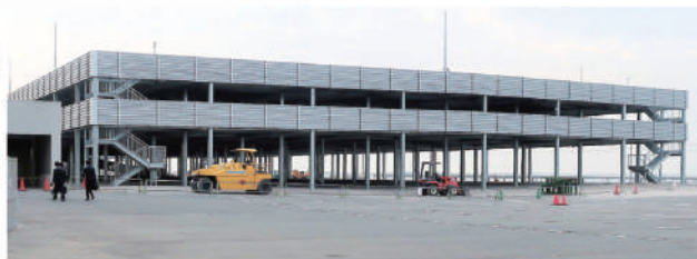
2階3層の立体駐車場を新設
