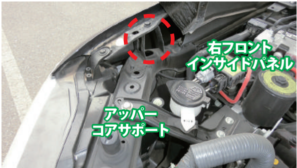
画像② フェンダーの取付ステーに歪みはないか？ (画像は新車状態)
