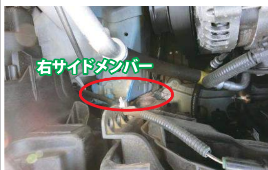
画像③不自然な隙間が発生していないかを確認 (同)
