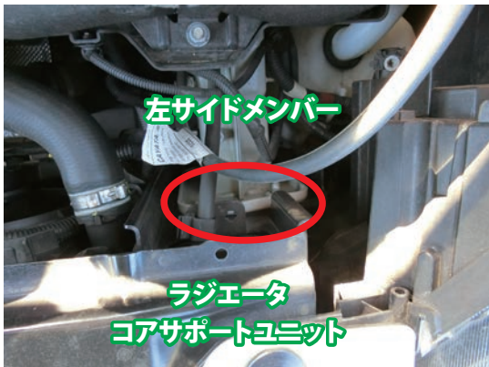
画像③ 不自然な隙間が生じていないか? (画像は新車状態)
