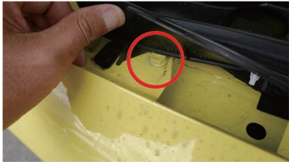
画像② フロントフェンダーの取付ボルト
