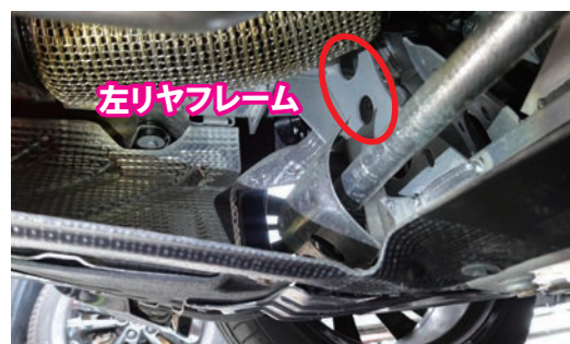
画像⑤ 打ち抜き穴に歪みがないか？ (同)
