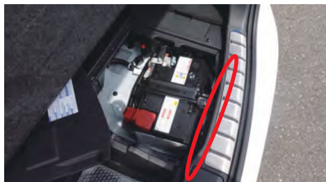
画像⑤ 接合部のシーラントに異常はないか？
