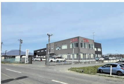
写真右手の駐車場が建設予定地
