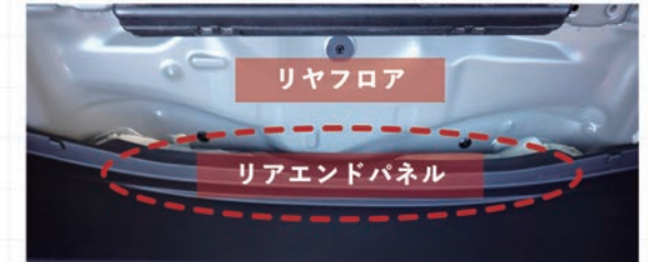
画像④接合部に塗布されたシーラントも確認(同)
